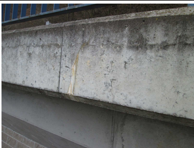
Bok římsy. Ojedinělé stopy průsaků trhlinami. Povrch znečištěn.
